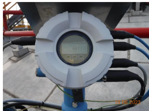
รูปที่ 3.59 อุปกรณ์วัดอุณหภูมิ และระดับของเหลว ในถังเก็บไฟฟ้าพลังงานแสงอาทิตย์
