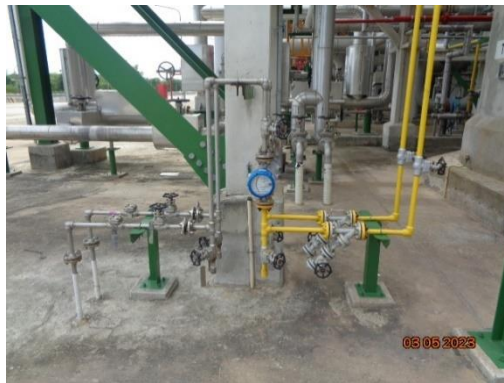
รูปที่ 3.39 ระบบก๊าซไนโตรเจนเพื่อปิดคลุม (Nitrogen Blanketing)
