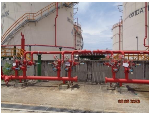
รูปที่ 3.40 ระบบน้ำฉีด (Water Spray) รอบผนังและหลังคาถังเก็บ
