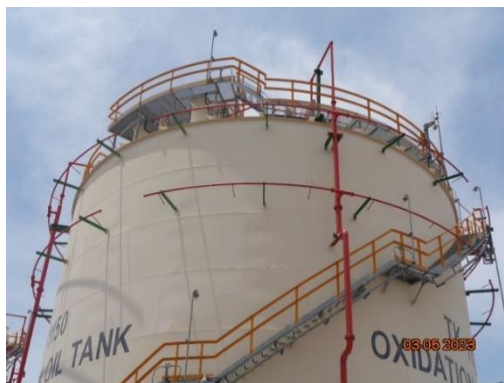
รูปที่ 3.40 ระบบน้ำฉีด (Water Spray) รอบผนังและหลังคาถังเก็บกัก (ต่อ)
