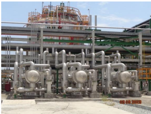
รูปที่ 3.56 ฉนวนหุ้มอุปกรณ์การผลิต ที่เกี่ยวข้องกับโพธิ์สินออกไซด์
