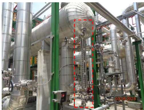
รูปที่ 3.50 Level Indicator ที่ถังเก็บกัก
