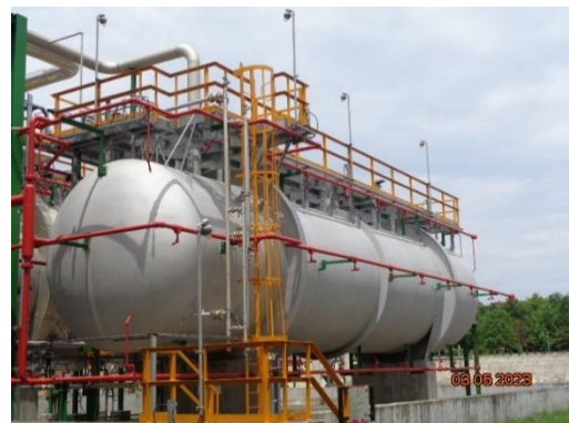
รูปที่ 3.40 ระบบน้ำฉีด (Water Spray) รอบผนังและหลังคาถังเก็บ
