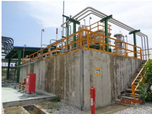
บ่อปรับสภาพ (Equalization Basin) และบ่อปรับให้เป็นกลาง (Neutralization Basin)
