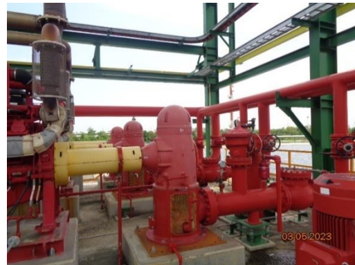
รูปที่ 3.47 เครื่องสูบน้ำดับเพลิง
